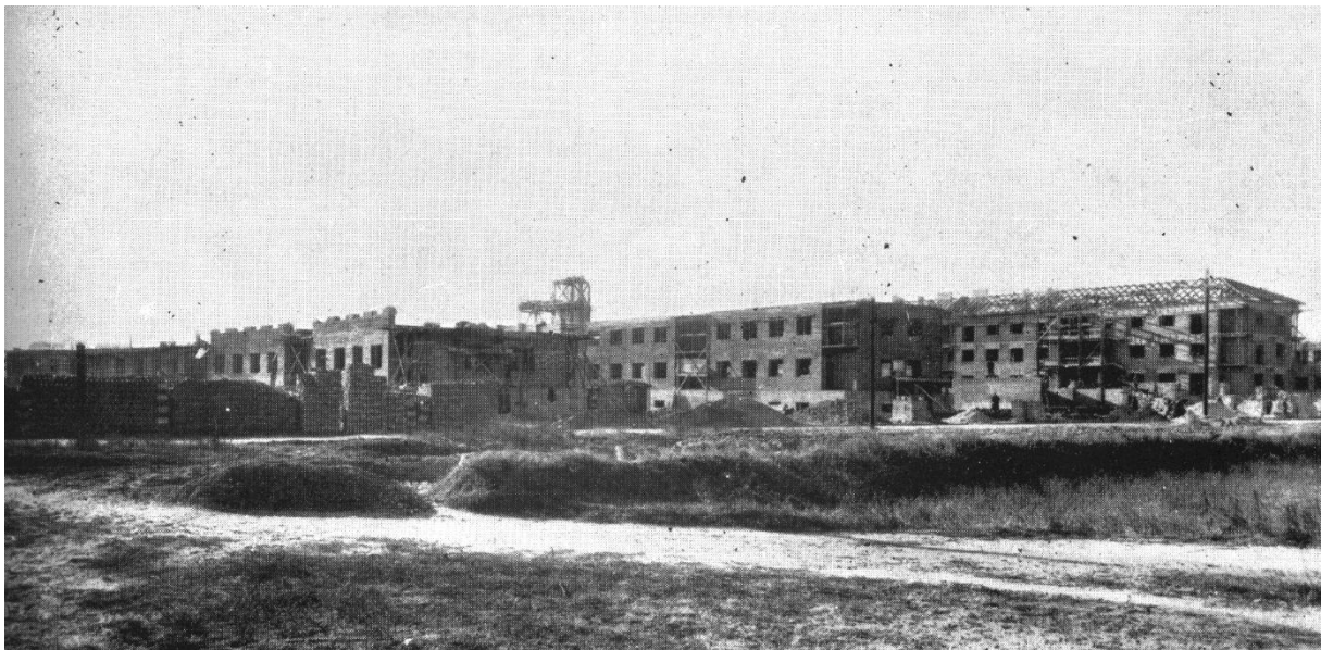
1940 a Hamzsabégyi úti telep építés közben / Halász 1941
