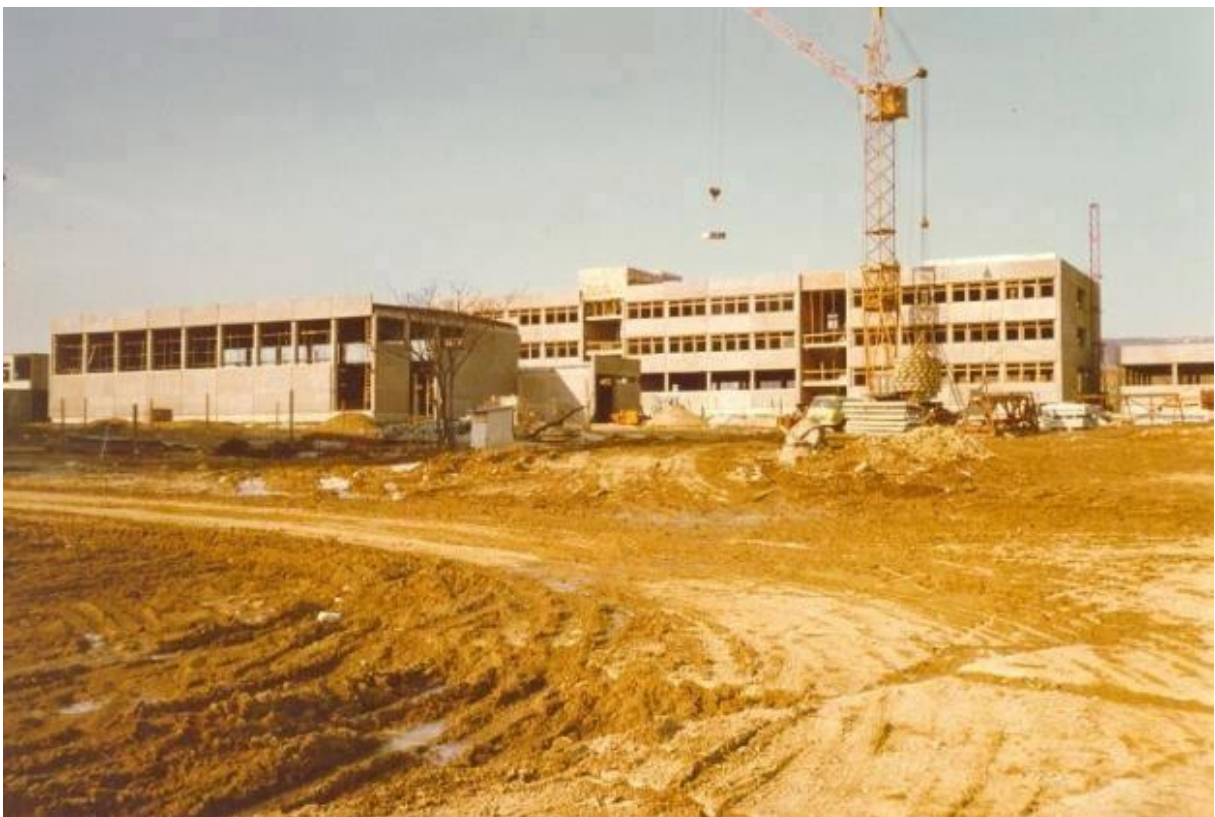
Törökugrató utcai iskola építése / Úbuda Anno Retro
