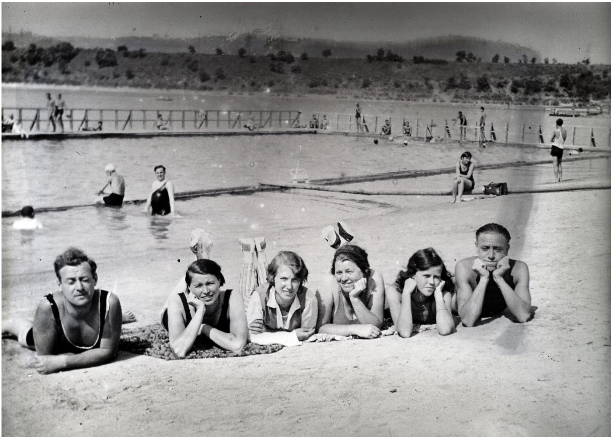
1929 Kopaszi gát / Fortepan - Hirschler Károly
